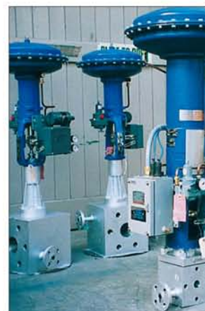
蒸汽保温夹套阀，应用于韩国的一个生产聚乙烯的化工厂。
