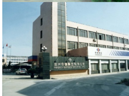
温州中德厂区
