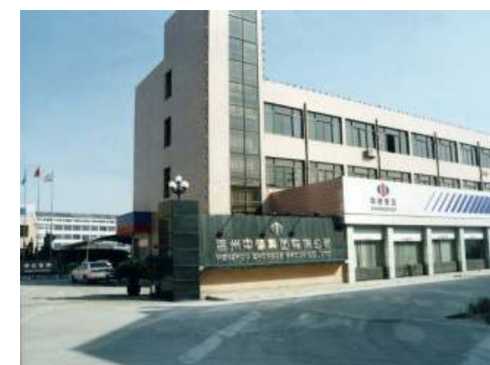
温州中德厂区
