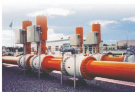
陕京输气管线北京衙门口末站 (DN500 ANSI400)
