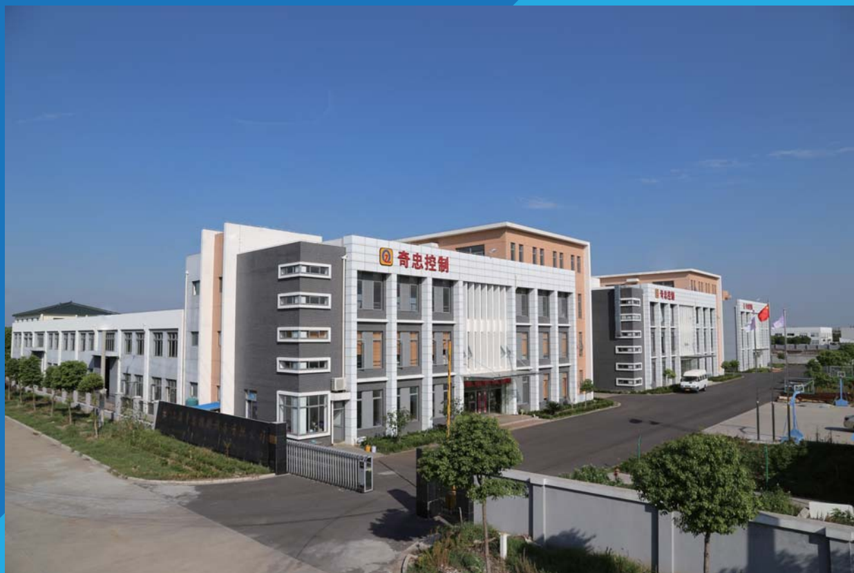
肯佐控制设备（上海）有限公司-上海工厂 KENZO - Shanghai Factory
